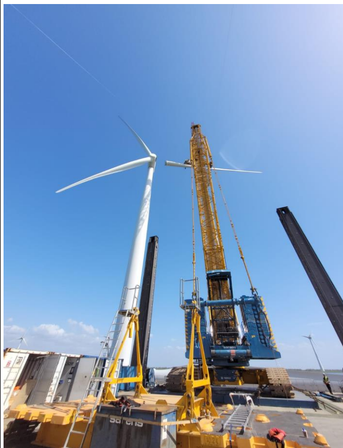
Foto van de vervanging van het rotorblad bij turbine 08, uitgevoerd door Siemens Gamesa RE met behulp van een speciaal kraanschip.
